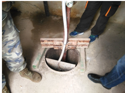
Pozo nº 4 Acuartelamiento: Boca del sondeo.
