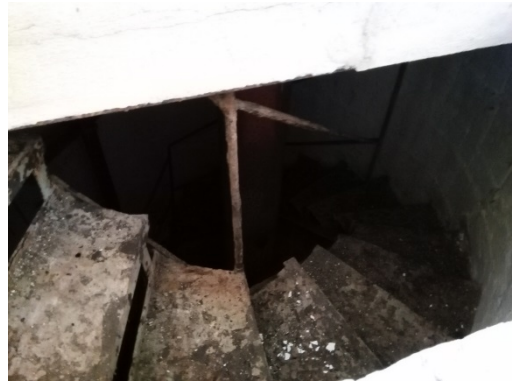
Pozo nº 2 Acuartelamiento: Detalle de la escalera de acceso al subnivel.
