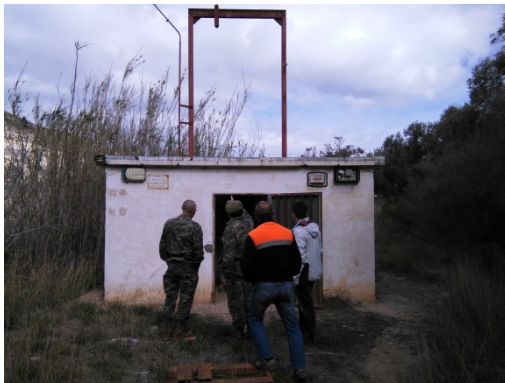
Pozo nº 4 Acuartelamiento: Caseta con puente-grúa.
