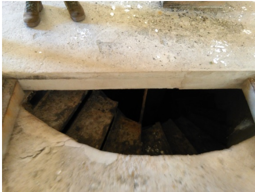
Pozo nº 2 Acuartelamiento: Escalera de acceso al subnivel.
