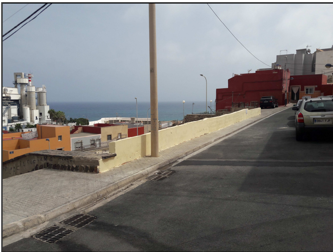
Fachada-alineación consolidada de la parcela por la calle Río Nervión – Linde Sur
