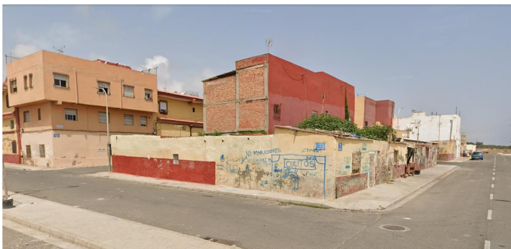
Imagen 14: Edificios del barrio del Cabrerizas en la trayectoria de apantallamiento.
