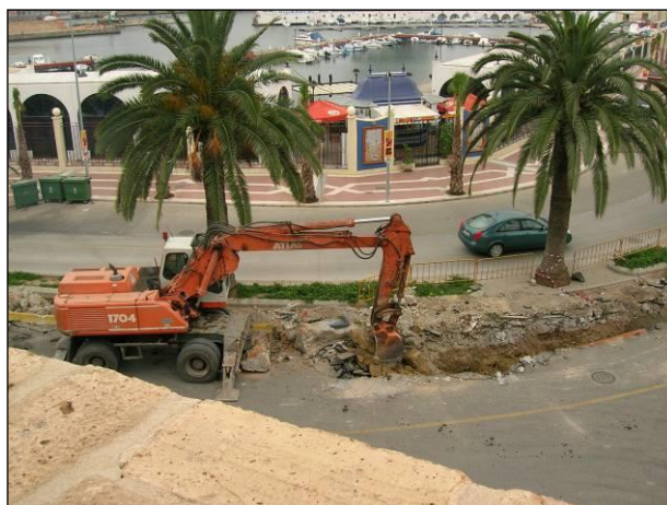
Extracción de los sillares del espigón.
