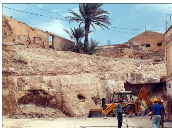
Fotografía de las obras desarrolladas (1995).
