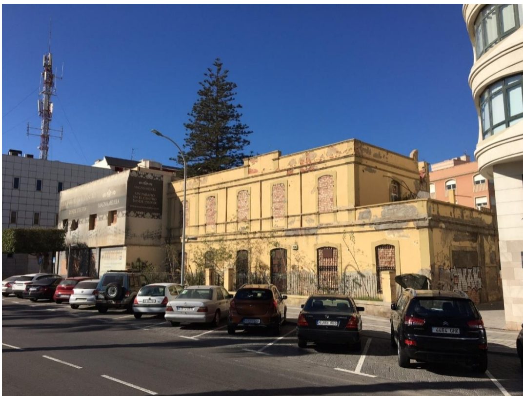
FACHADA AVENIDA MARINA ESPAÑOLA. VISTA DESDE EL ESTE.
