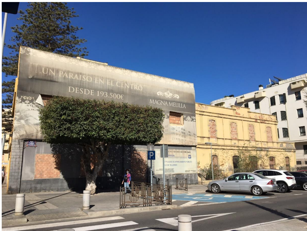
FACHADA AVENIDA MARINA ESPAÑOLA. VISTA DESDE EL SUR.
