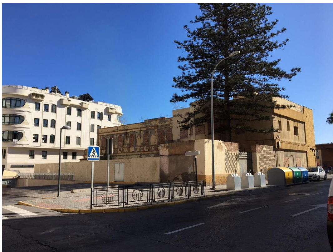
FACHADAS A CALLES VILLEGAS Y QUEROL. VISTA DESDE EL OESTE.
