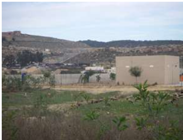
Depósito bombeo subálveo a balsa de las Adelfas
