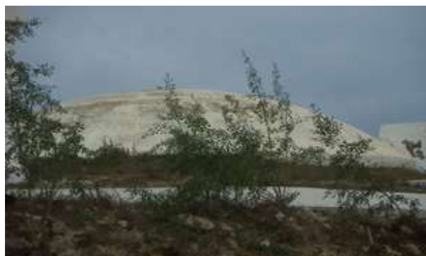
Depósito de Ataque Seco I
