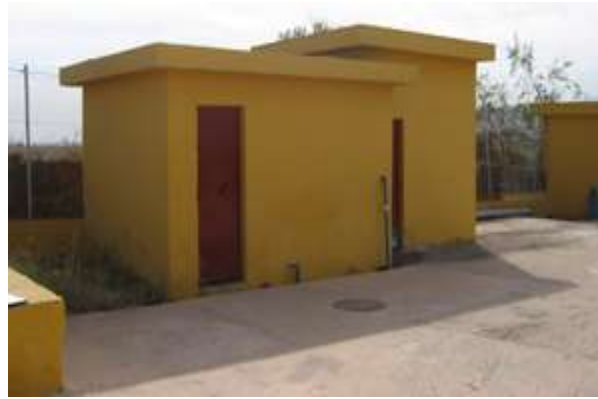
Estación Aeropuerto I
