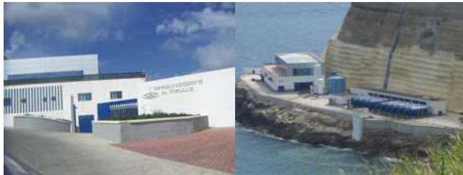
Desalinizadora de Melilla
