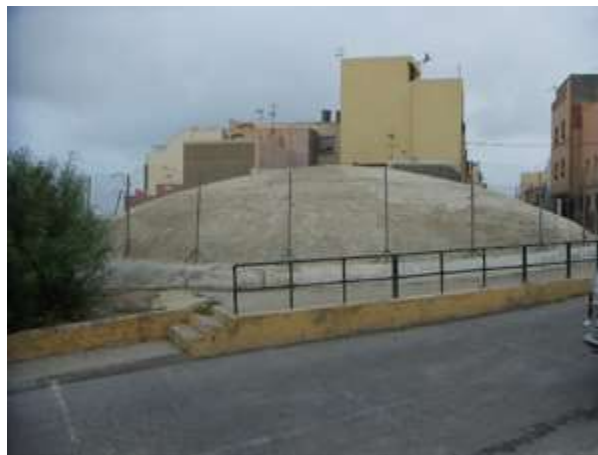
Depósito de Cabrerizas
